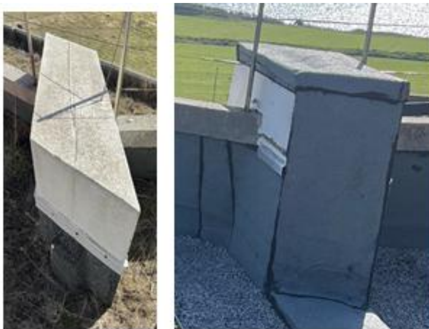
Figure n° 06 _ JD à étanchéifier + exemple rendu à obtenir
