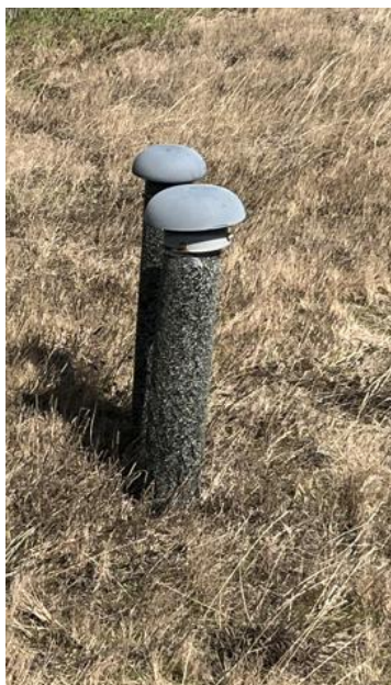
Figure n° 04 _ ventilations de chutes existantes
